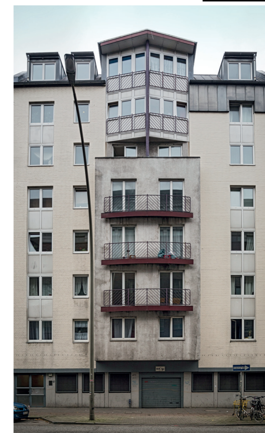
DAS GEBÄUDE IN DER DER SIMON-VON-UTRECHT-STRASSE 66, DESSEN BEWOHNER_INNEN HILFE BEI DER GWA GESUCHT HABEN
